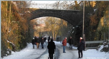
Die Nordbahntrasse verknüpft die Parkpromenade mit vielen Stadtteilen.
